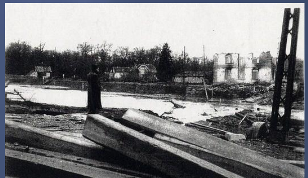
Le pont de Krafft après sa destruction
